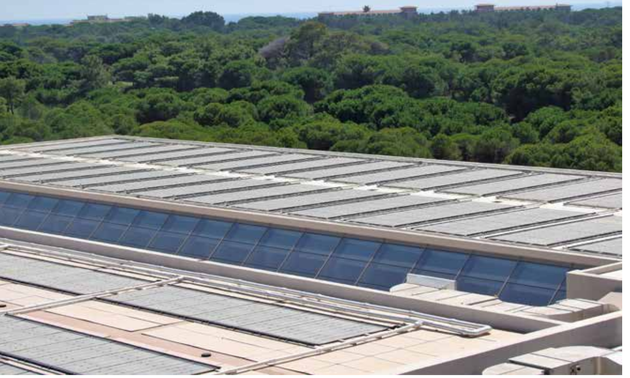
Resim 4. Açık havuzların ısıtmasına hizmet eden EPDM polikarbonat kılıflı yeni nesil, çatıya serilebilen formda güneş kollektör sistemi.
