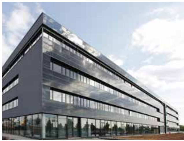
Şekil 4 Bina ile bütünleşen ve dış cephe kaplama malzemesi olarak kullanılan güneş pilleri [5]
