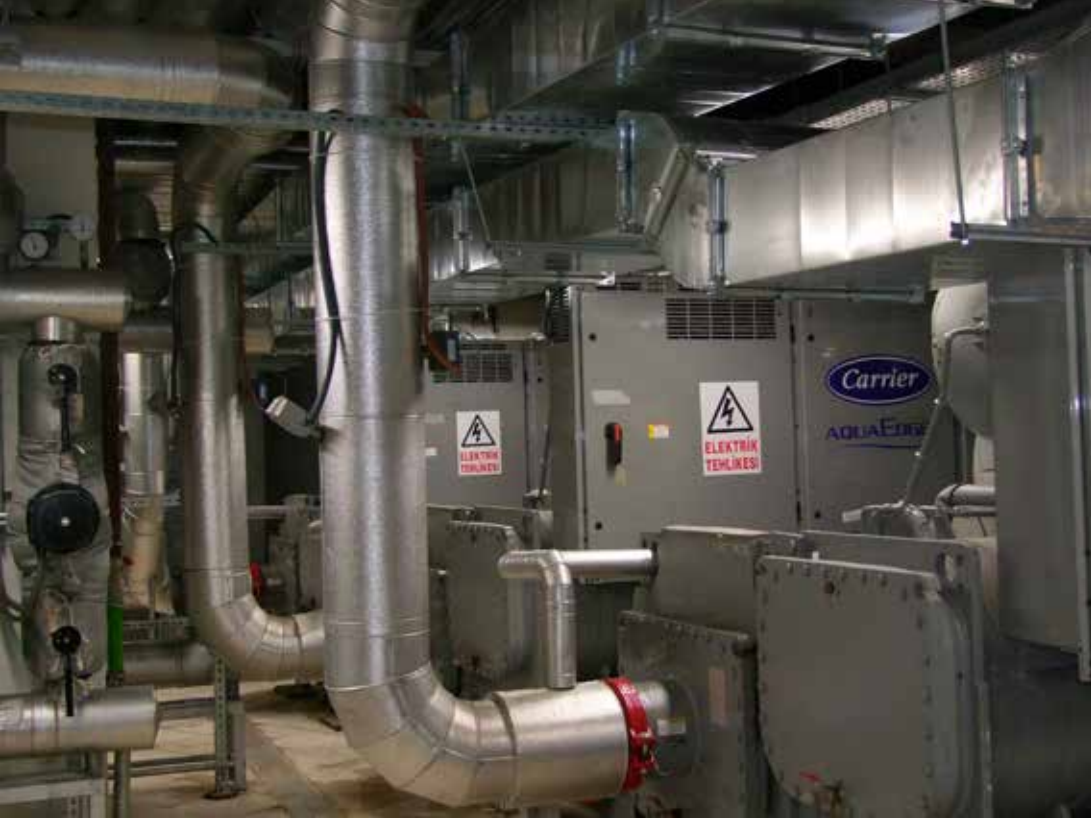
Resim 3. Türkiye’de ilk defa bu projede kullanılan yüksek cop değerine sahip frekans invertörlü vidalı kompresörlü su soğutmalı soğutma grupları.
